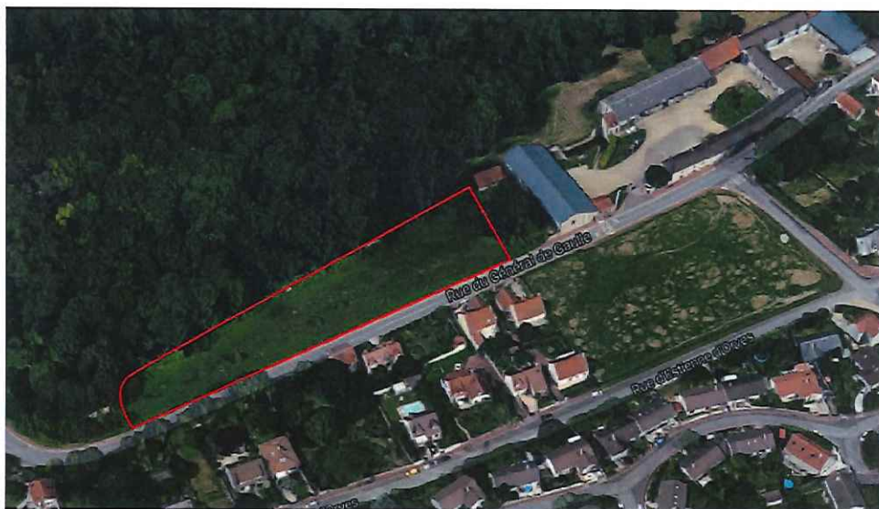
Figure 3 Vue aérienne du site ; Source Google Map
